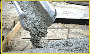
Cement Slab Pouring
